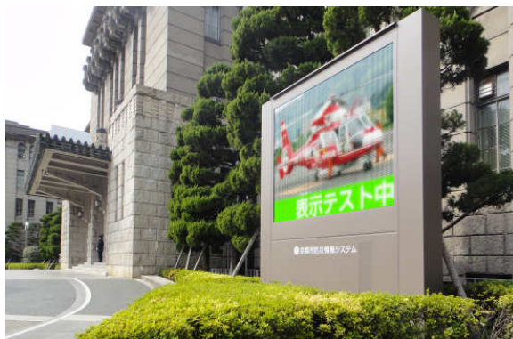
▲京都市役所前に設置された災害情報表示・音声システム
